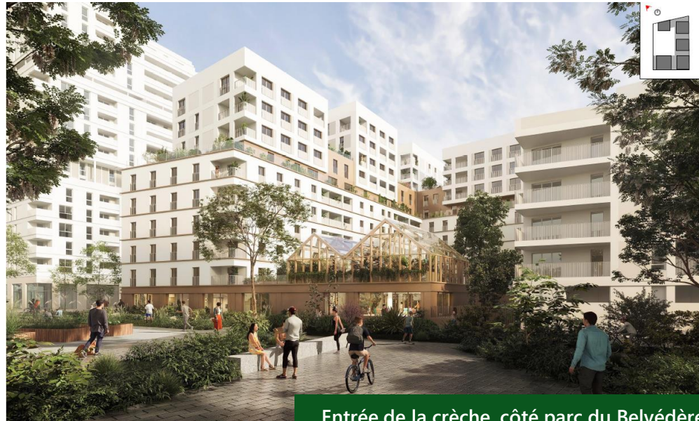
Entrée de la crèche, côté parc du Belvédère
