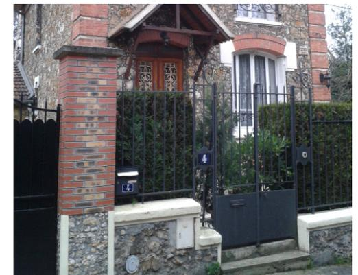
*Les murs en pierre et les murs bahuts doivent être hourdés et enduits à pierres vues au mortier de chaux, surmontés d'un chaperon.*
