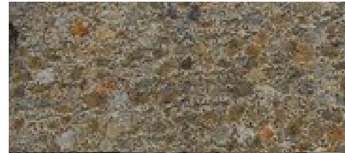
*Façade en meulière : nettoyage des sulfates par un lavage à l'eau et à la brosse, suivi d'un micro-sablage à faible pression légèrement humide et savons désincrustants accompagné d'une reprise des joints si nécessaire. Réparations des parties dégradées, par incrustation ou par remplacement, suivi d'une reminéralisation de la façade par un enduit à la chaux.*
