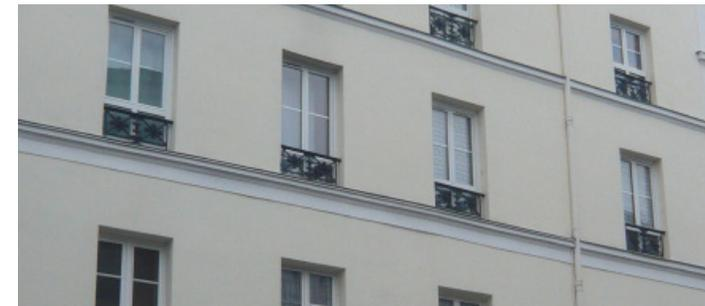
*L'enduit plâtre et chaux est traditionnellement lissé*
