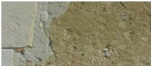
**Les enduits modernes, généralement à base de ciment adjuvés de produits artificiels, et souvent retenus parce que prêts à l'emploi, sont inappropriés : ils donnent un aspect « standard » uniformisant les constructions, et peuvent être destructeurs pour les maçonneries qu'ils empêchent de respirer**
