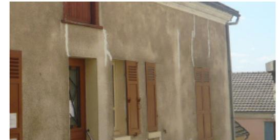
Enduits ciments sur maçonnerie traditionnelle : supprimer les enduits étanches
