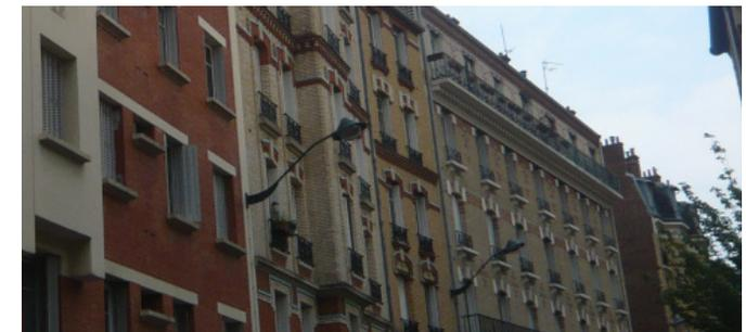
*La couleur du joint doit être la même que celle de la brique*
