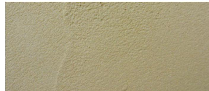
*L'enduit ciment cause de désordres importants est à proscrire sur les maçonneries traditionnelles en moellons de pierre*
